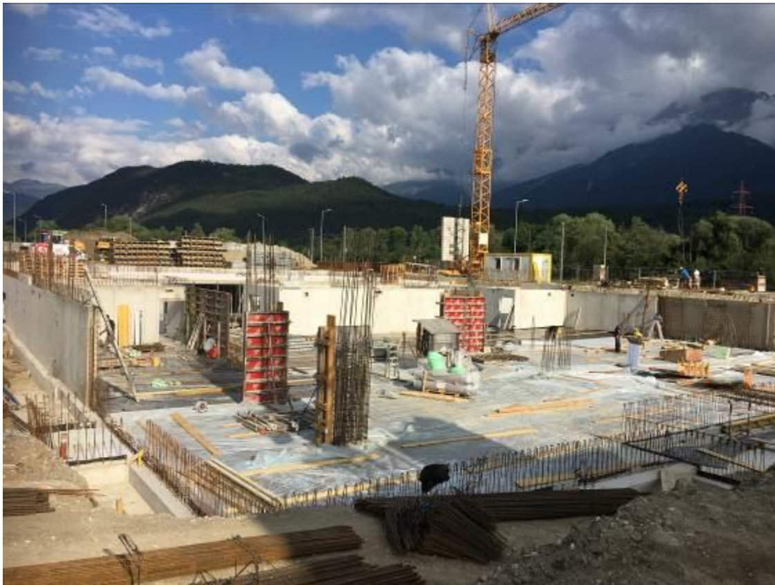
Autopark Telfs-Pfaffenhofen, Arbeiten an der Tiefgarage, Stand Juni 2018
